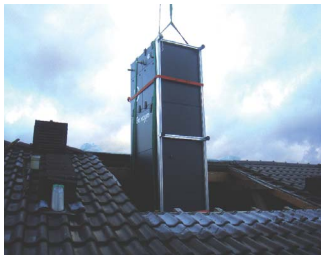
Habifox HF 2 H Einbringung durch Dachöffnung
